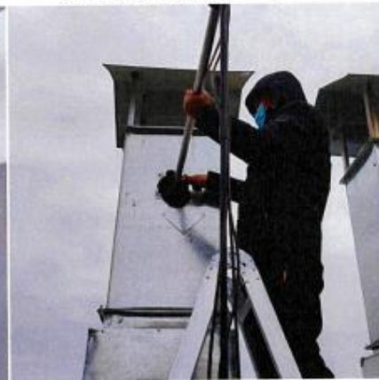
废气设施处理后 (DA004) ⊙
