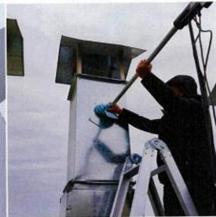
废气设施处理后 (DA005) ⊙
