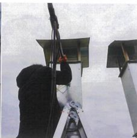
废气设施处理后 (DA006) ⊙
